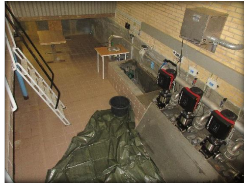
Dækket er ca. 1.5 m under terræn.
