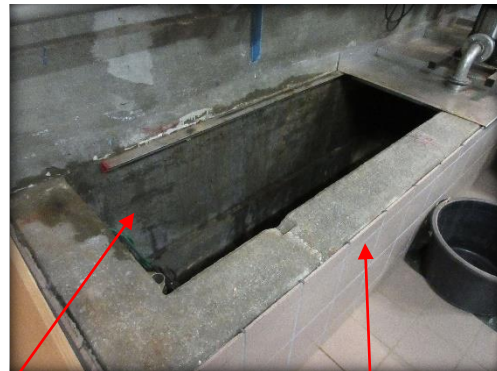
Nedgangen er hævet over gulvet.
