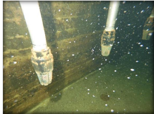
Sugerørene sidder højt fra gulvet.
