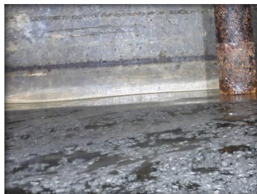
Der er meget kalk i overfladen.
