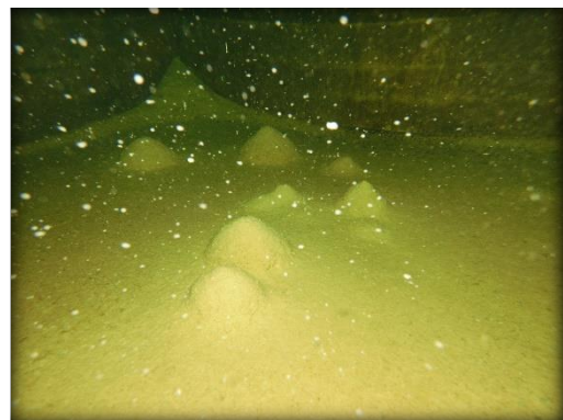
Kalk toppe fra kondens dryp.
