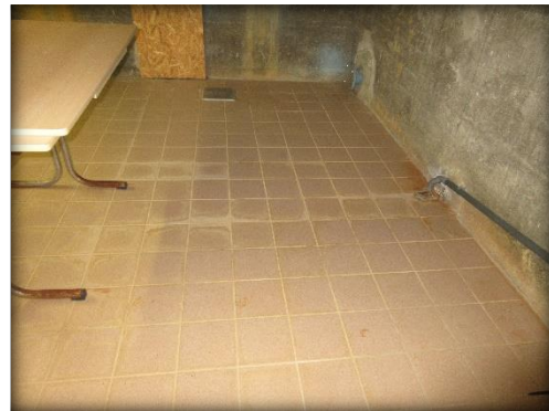
Klinkerne på beholderen er uden synlige revner.
