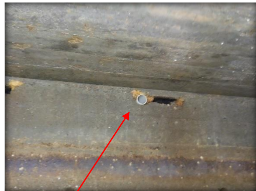
Rør til luftudligning i skillevæg.
