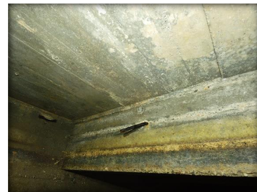
Helt loft uden skader eller revner.
